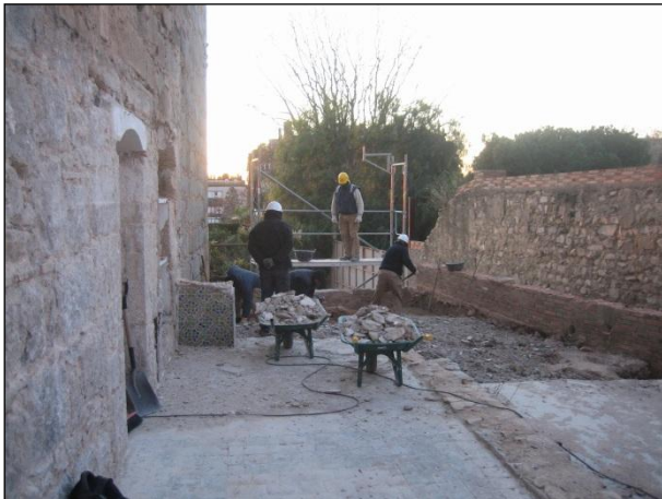
FOTO 109. Tasques de retirada del paviment de formigó ue 03.
