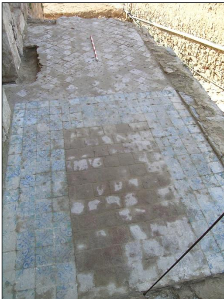
FOTO 85. Paviment de la planta superior.
