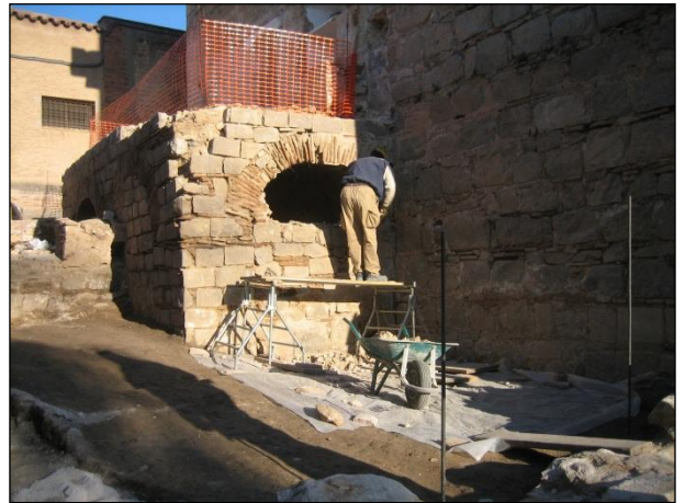
FOTO 20. Retirada del paretat (ue 36) del l'arcada de migdia de l'edifici d'arcades ue 01.
