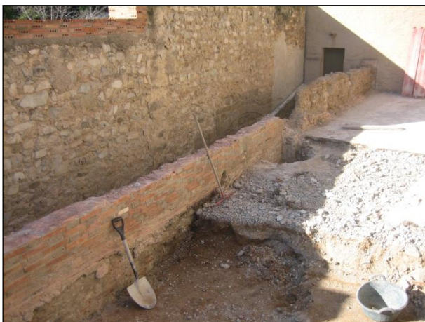
FOTO 11. Treballs de retirada del paviment de formigó (ue 03) i de l'estrat de runa que l'anivellava (ue 04).
