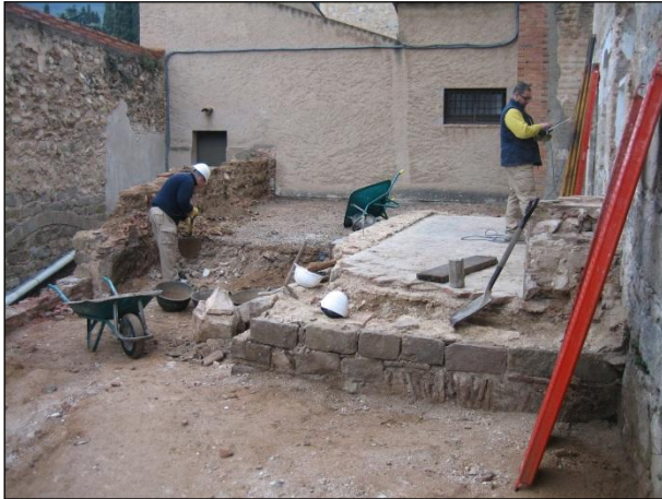
FOTO 13. Treballs de retirada del paviment de formigó (ue 03) i de l'estrat de runa que l'anivellava (ue 04).
