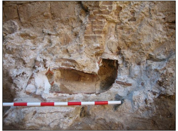
FOTO 80. Detall de la colzada de la canonada on s'intervingué per desembussar-la.
