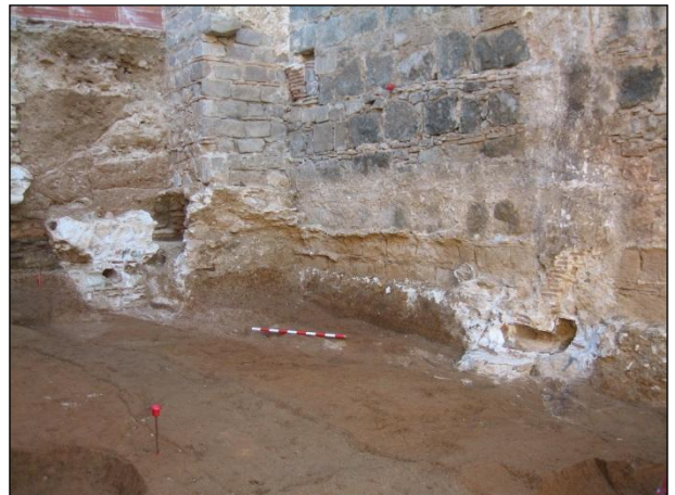
FOTO 78. Detall de la connexió de la canonada d'aigua cap a l'interior del parament de la infermeria (dreta).
