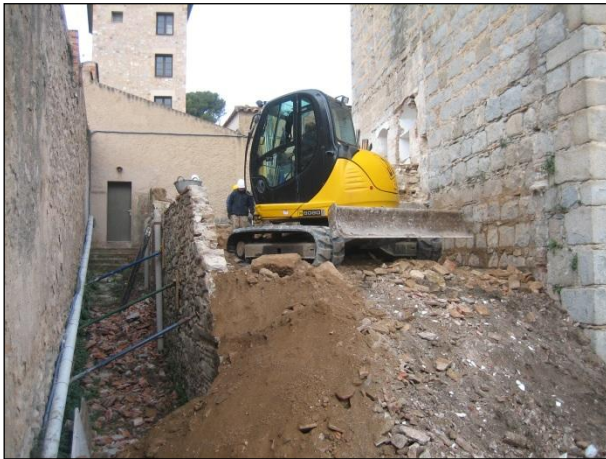
FOTO 19. Màquina giratòria pujada sobre el terraplè per tal d'accelerar el procés de retirada de runa.
