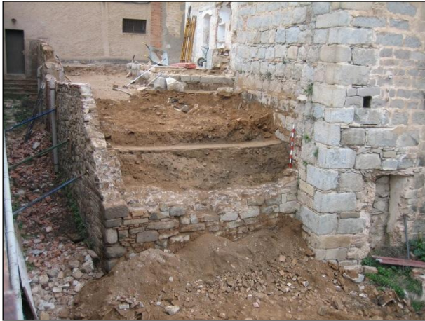
FOTO 17. Durant el control mecànic de la retirada de l'estrat ue 04, localització del paviment de maons ue 06.
