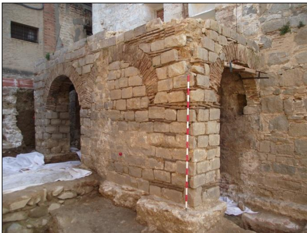
FOTO 81. Nivell inferior de l'edifici d'arcades 01.
