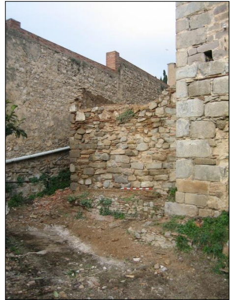
FOTO 14. Frontal del mur de contenció ue 02 durant el procés d'enderroc manual..
