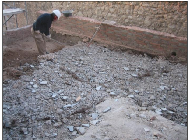
FOTO 100. Tasques de retirada del paviment de formigó ue 03.
