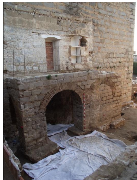
FOTO 82. Nivell inferior de l'edifici d'arcades 01.
