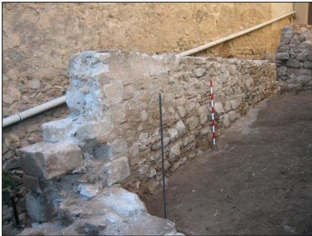
FOTO 103. Mur de contenció ue 02 a la zona del femer.
