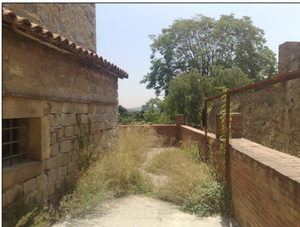
FOTO 9. Vista general del terrat de la infermeria abans de la intervenció.
