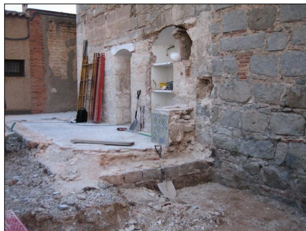
FOTO 12. Vista del pis superior de l'edifici d'arcades (ue 01) un cop enderrocat.
