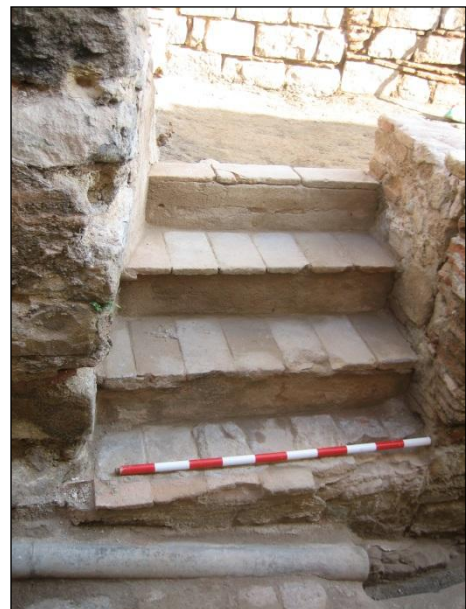
FOTO 106. Detall de les escales d'accés des del camí de l'amargura a la terrassa superior.
