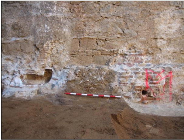
FOTO 79. Detall de la pujada (esquerre) i baixada (dreta) de la canonada d'aigua.
