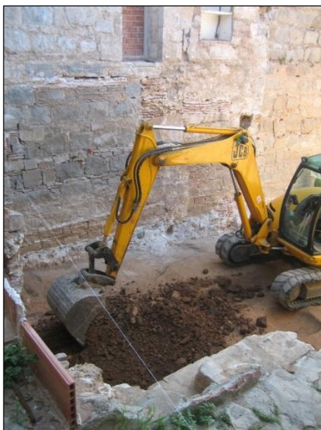
FOTO 31. Rebaix mecànic controlat un cop finalitzada l'excavació manual.
