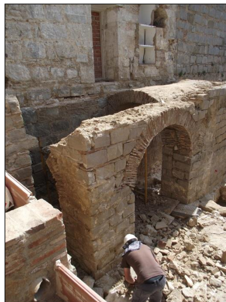
FOTO 24. Desmuntatge manual de l'edifici d'arcades
