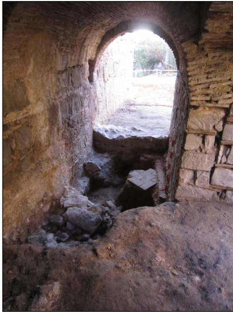
FOTO 99. Rasa de reparació (ue 61) de la canonada d'aigua a l'interior de l'edifici d'arcades..
