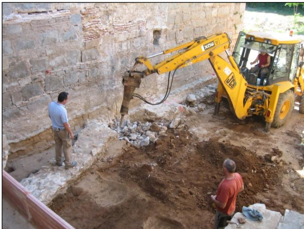
FOTO 29. Desmuntatge mecànic de la canonada d'aigua (ue 73 i 100) arran de l'edifici de la infermeria.
