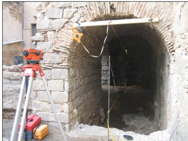
FOTO 22. Procés de documentació planimètrica de l'edifici d'arcades ue 01. En aquest cas, secció longitudinal A-A'.
