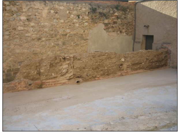
FOTO 108. Parament de tàpia ue 05 construït a sobre del mur ue 13.
