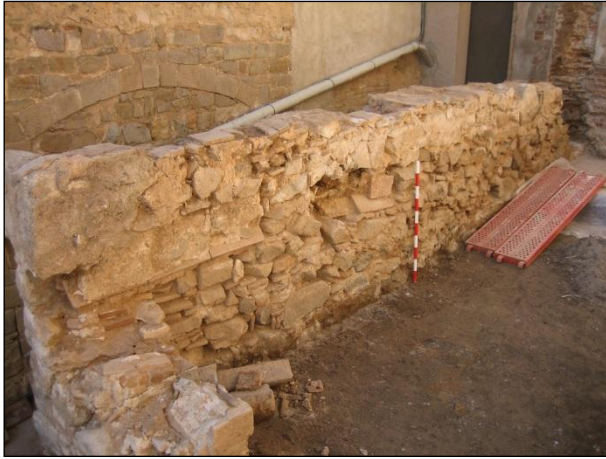
FOTO 107. Parament del mur ue 13.
